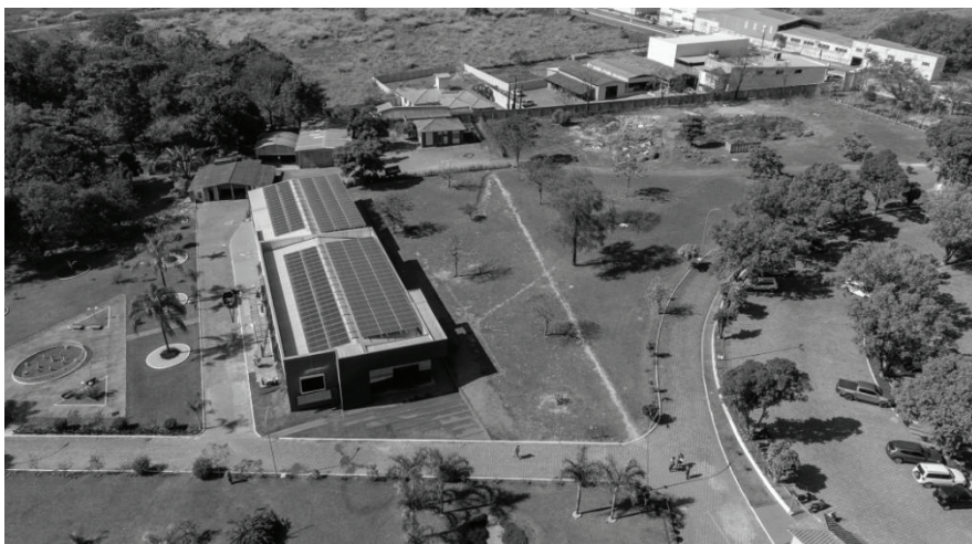
O prédio da Academia PTCFITNESS, no telhado as placas da usina fotovoltaica, importantes obras de Ênio Leal no contexto pandêmico da COVID-19.Foto: Arquivo do PTC.
