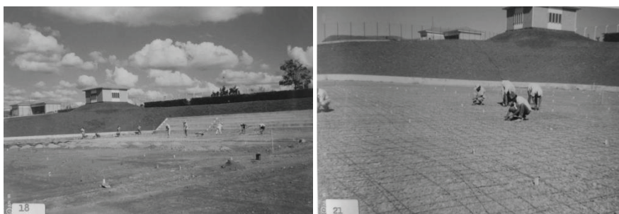
À esquerda, operários trabalham aplanando o terreno e à direita preparam as ferragens para a concretagem das quadras. Observe; o "Castelinho" e portaria já estavam prontos e ficaram imponentes nas fotos . Foto: Arquivo da Família Moreira da Silva.
