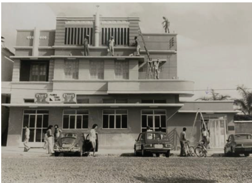
Fachada do PTC em reforma. Foto: Arquivo da Família Moreira da Silva.
